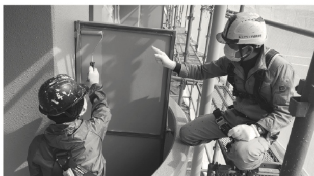
塗装作業の様子
